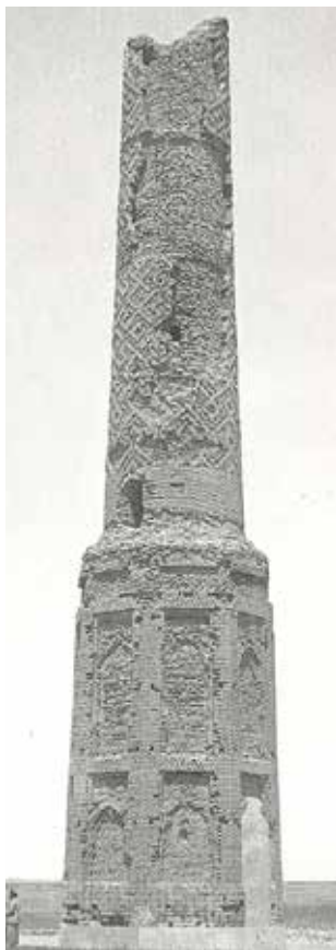
منارة اربيل قبل الترميم
